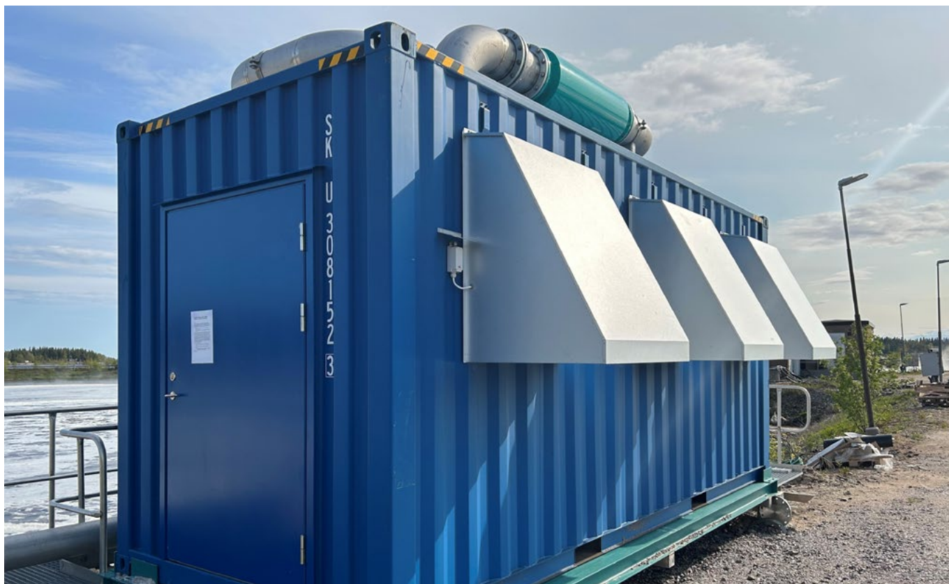
Blåsmaskiner i vattenreningscontainern syresätter avloppsvattnet för att bakterierna som äter kväve och fosfor ska trivas. Bild: Atek
