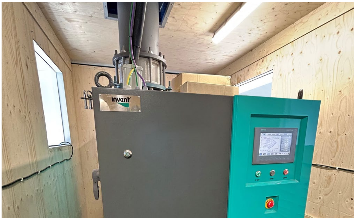
Blåsmaskiner syresätter avloppsvattnet för att bakterierna som äter kväve och fosfor ska trivas. Bild: Atek
